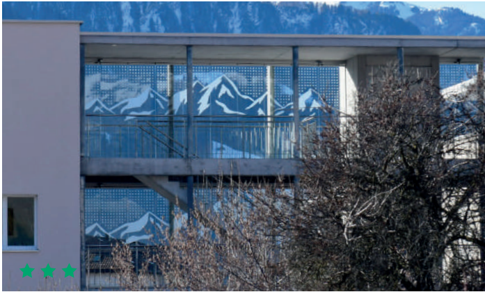
Abbildung 12: Verglaste Verbindungstrakte sind klassische Vogelfallen. Dieses Altersheim hat mit dieser dekorativen Lösung vorbildlich nachgerüstet. © Christoph Meier-Zwicky
