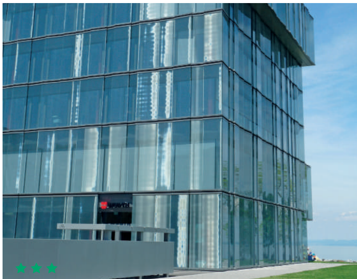
Abbildung 9: Gebäudehülle mit metallbedampftem Gewebe im Scheibenzwischenraum. Eine Überwachung während eines Jahres bestätigte, dass es zu keinen Kollisionen kam. © Archiv Schweizerische Vogelwarte
