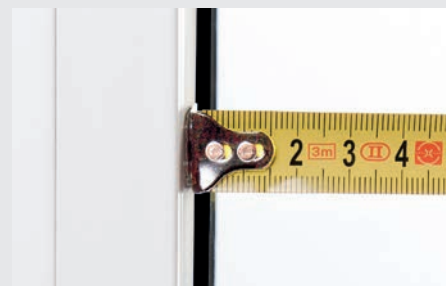
Gummidichtung schmaler als 5 mm
