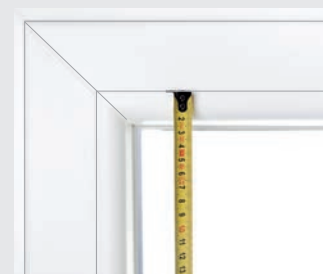
Empfohlener Messpunkt: Glasleistenfuge
