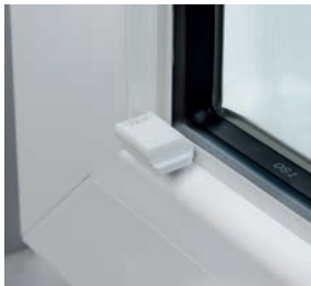
runde Glasleiste (Tiefe min. 9 mm)
