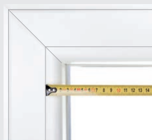
Empfohlener Messpunkt: Glasleistenfuge ggf. auf Beschläge achten
