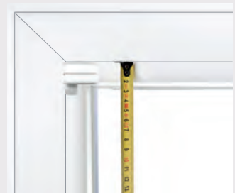
Empfohlener Messpunkt: Glasleistenfuge
