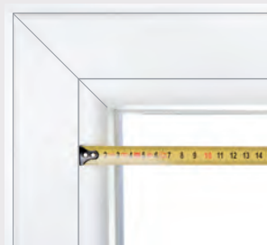
Empfohlener Messpunkt: Glasleistenfuge ggf. auf Beschläge achten
