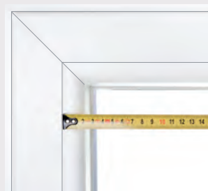
Breite: Empfohlener Messpunkt: Glasleistenfuge ggf. auf Beschläge achten
